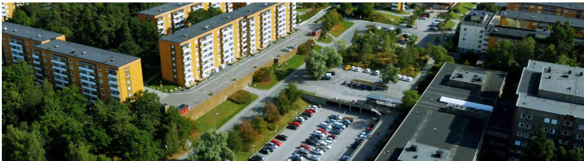
Del av centrala Högsåtra med Högsåtravägen i befintligt läge och Högsåtrahuset med parkering.
