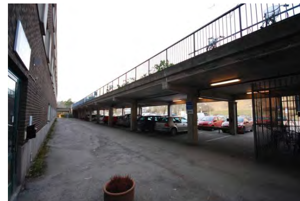
Upphöjd gång- och cykelbana framför Högsätrahuset.
