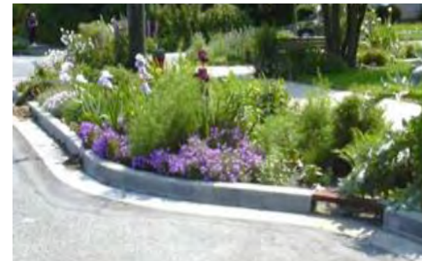
Regngårdar är större lösningar för dagvatten som kan hantera stora flöden och bli positiva inslag i stadsbilden.
