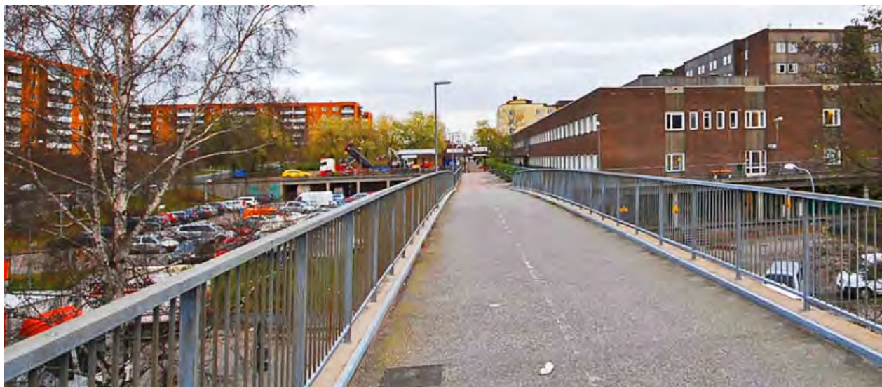
Gångbron över Läroverksvägen.
