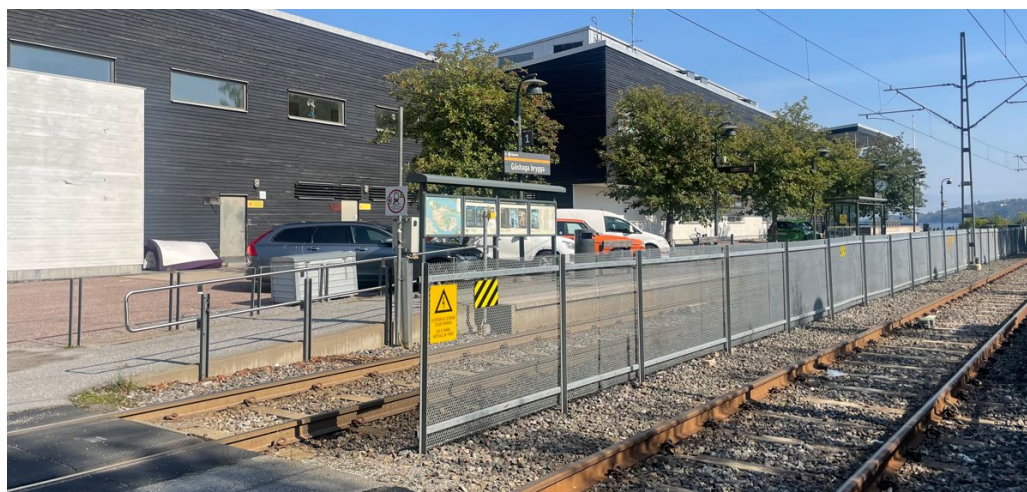
Byggnaden på Stapelbädden 9 sedd från söder med Lidingöbanan och hållplatsen Gåshaga brygga i förgrunden.
