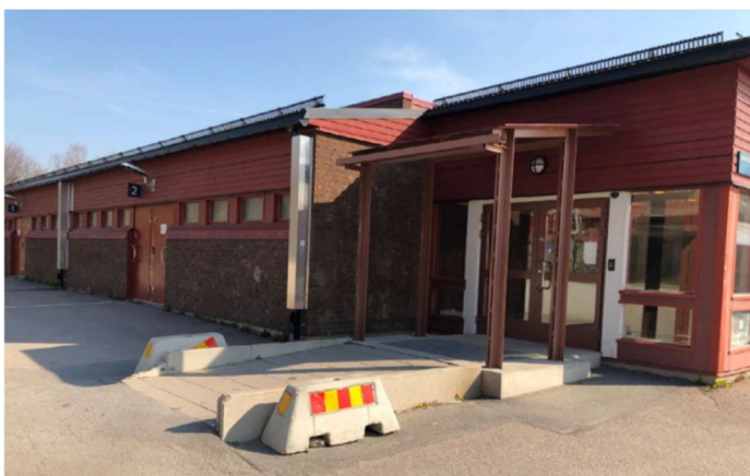
Sporthallens västra fasad med huvudentré.
