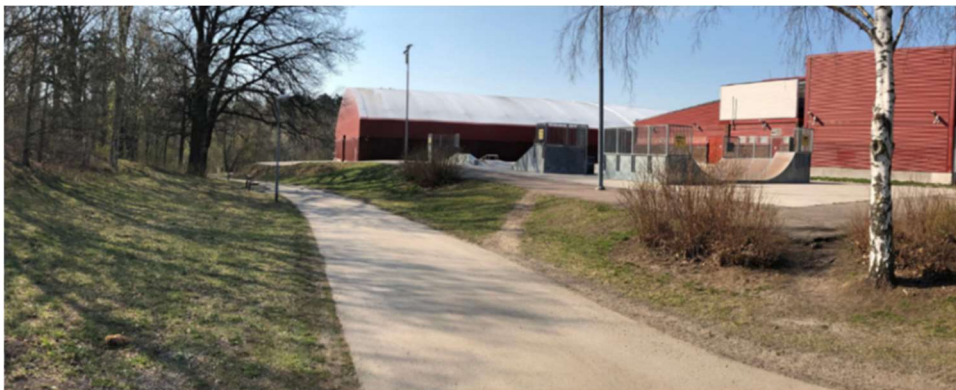
Platsen vid ishallens baksida som i dag används för skateramper blir möjlig att bebygga. Ekdungen på motstående sida av gång- och cykelvägen kommer fortsatt att vara skyddad som naturmark.
